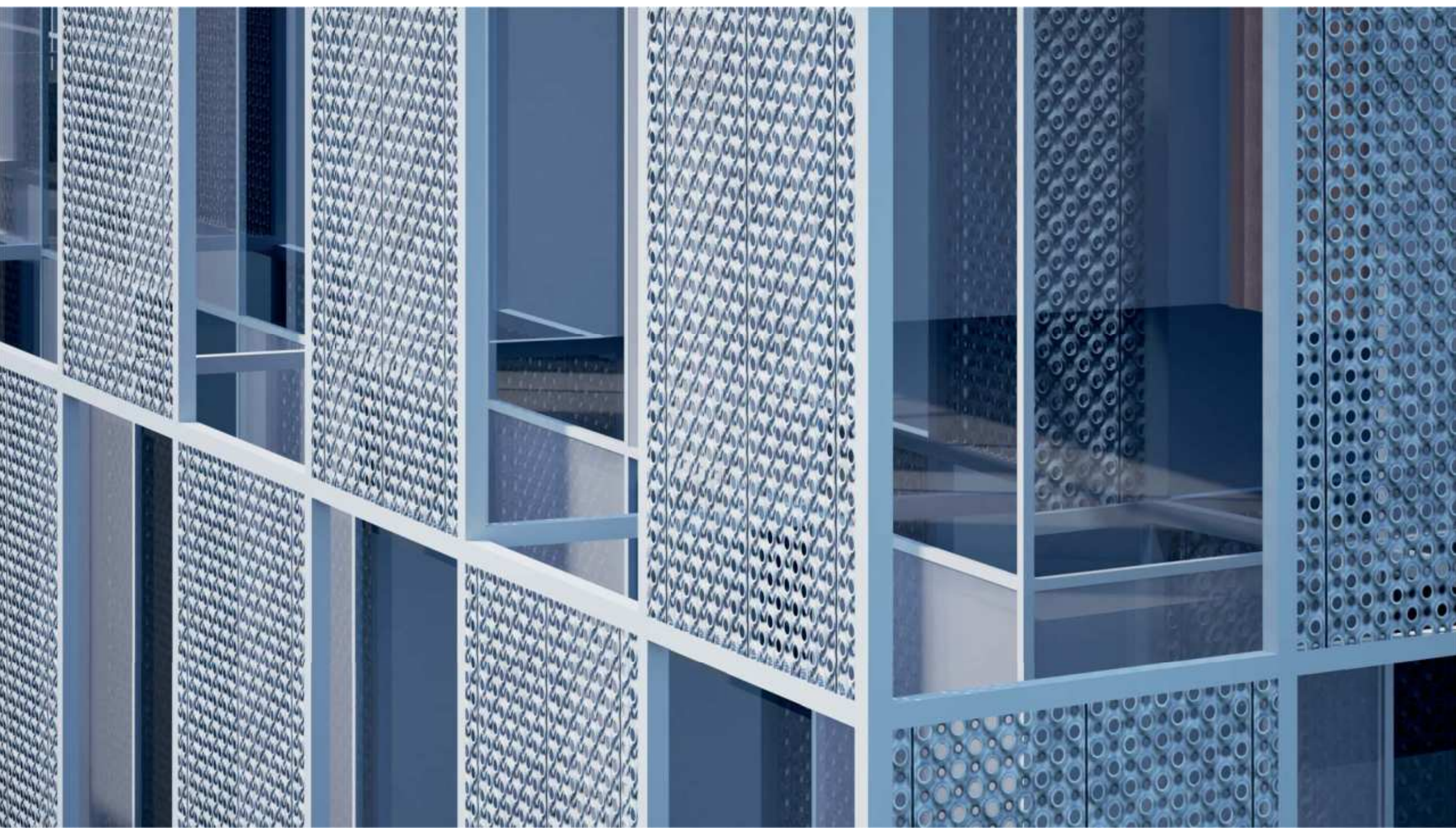
DETAIL - PERFOROVANÝ ROŠT NA OCELOVÉM RÁMU, PŘEDSAZENÁ STÍNÍCÍ FASÁDA
